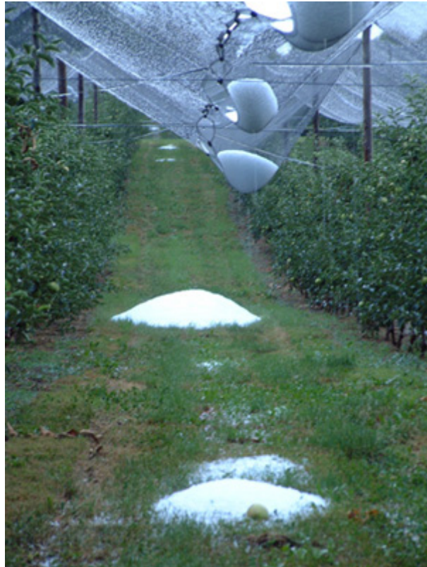
Der beste Schutz ist die passive Hagelabwehr mit Hagelschutznetzen.
