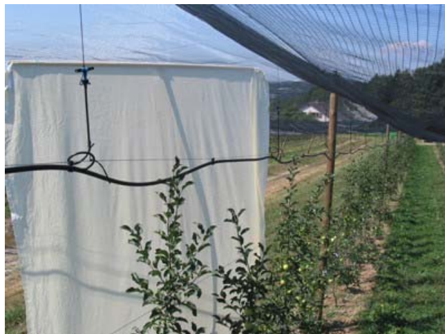
Durch Überkronenberegnung mit Mikrosprinklern wird nicht so viel Wasser verbraucht wie bei der herkömmlichen Überkronenberegnung.
