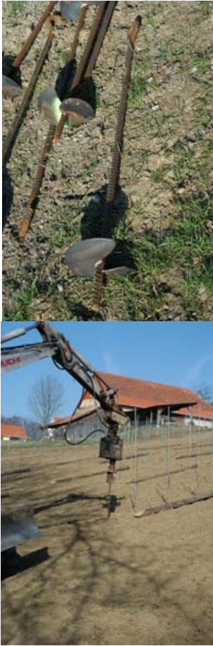
Zuerst müssen die Anker gut im Boden verschraubt werden.
