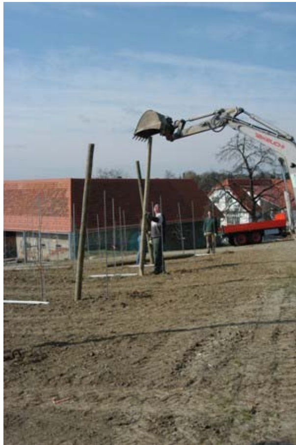
Danach werden die Säulen des Stützgerüsts in den Boden geklopft.
